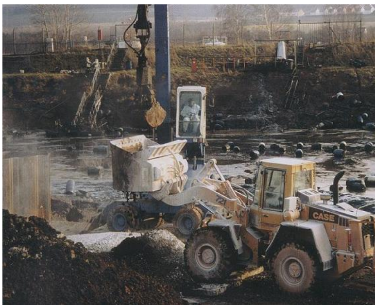
Рис. 7 Извлечение и транспортировка сернокислого гудрона
